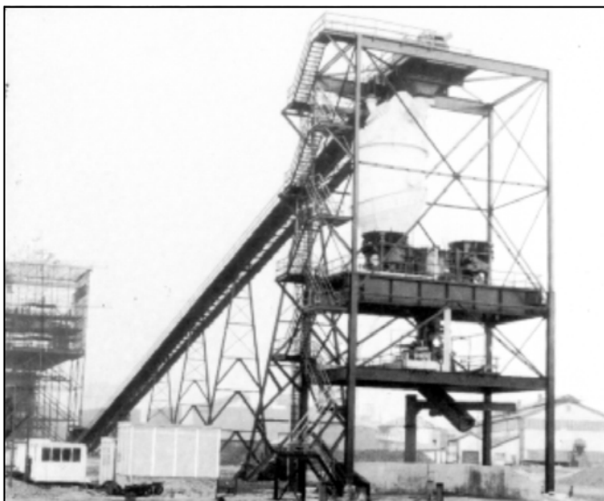
PAUL WURTH TEST RIG
